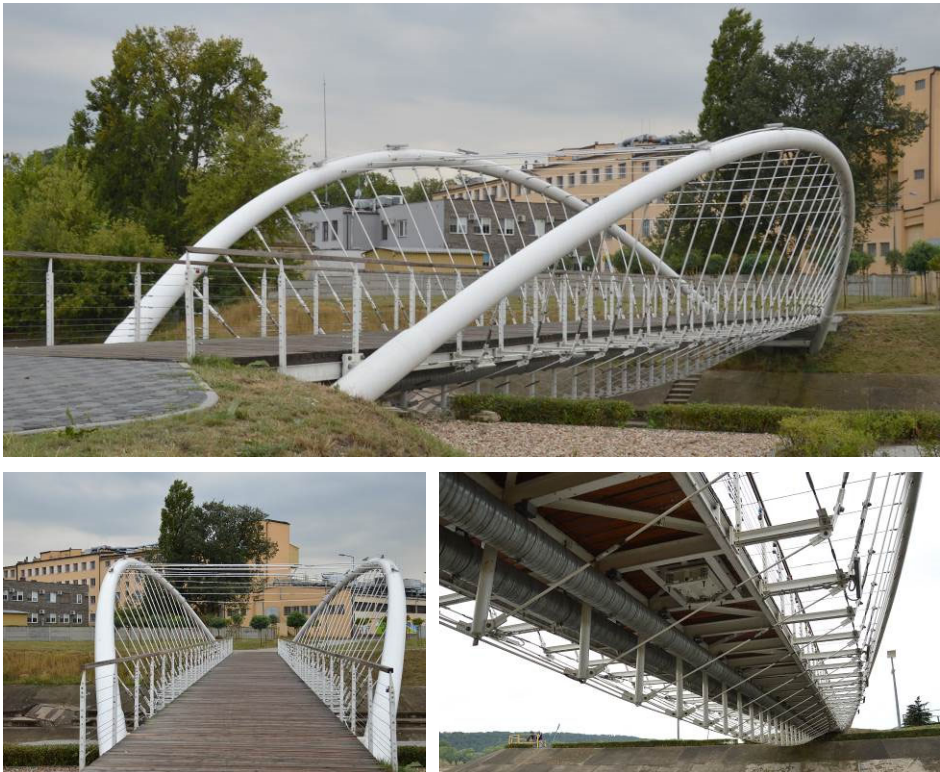
Fig. 3. General view of the arch footbridge over Zgłowiączka river in Włocławek, Poland.
