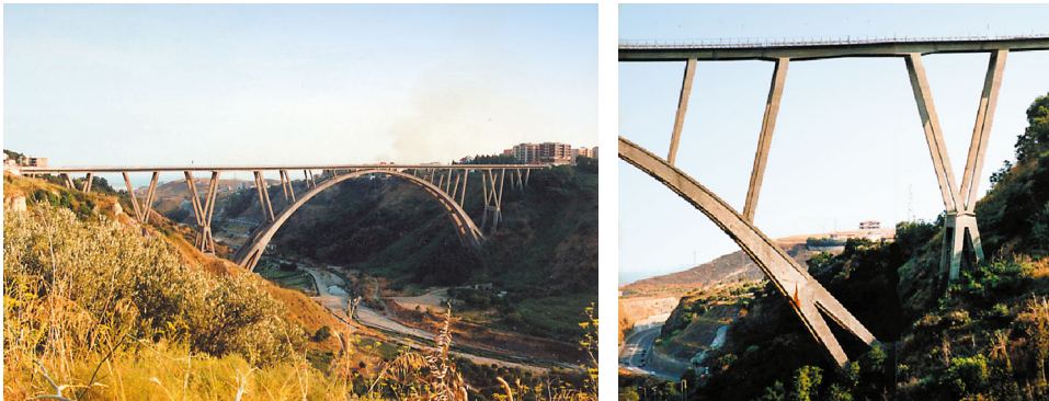
Fig. 4. R. Morandi, the Fiumarella Viaduct, Catanzaro, 1958.
